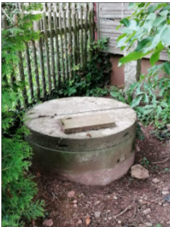
Der Pumpenschwengel ist bereits demontiert.
