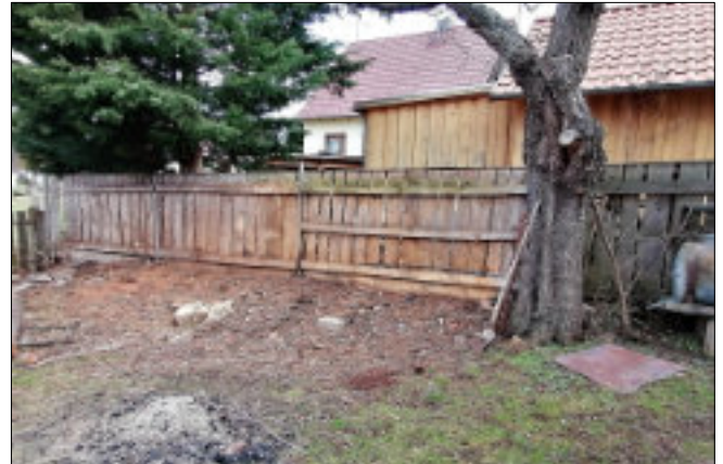
Das Provisorium ist beseitigt, Platz für das neue Lager geschaffen. (Februar 2023)
