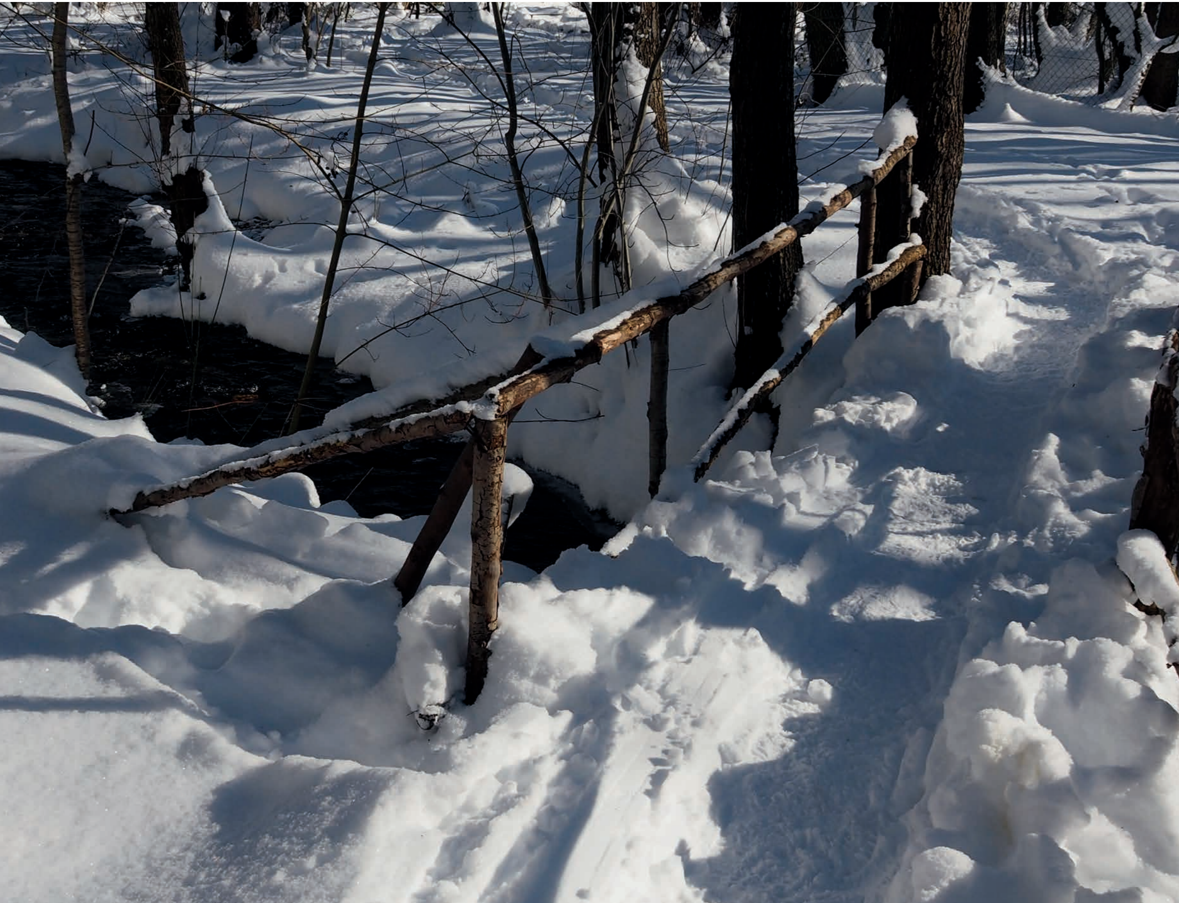
Brücke im Bruch
